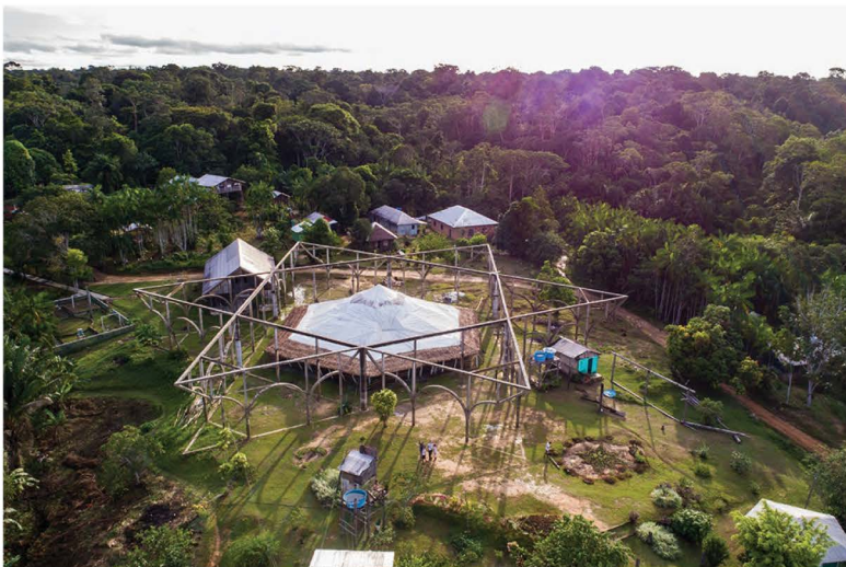
Vista aérea da obra da Igreja
