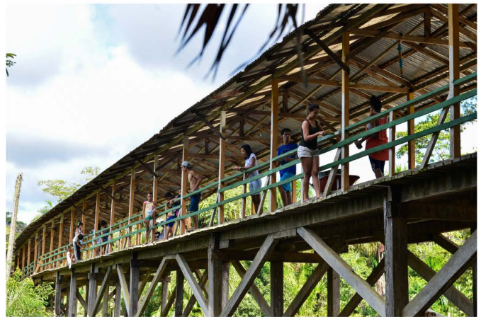
Reforma da ponte
