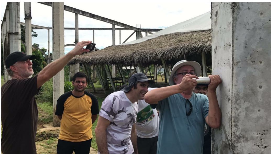
Engenheiros analisando o solo e as fundações, e realizando medição na estrutura de concreto.
