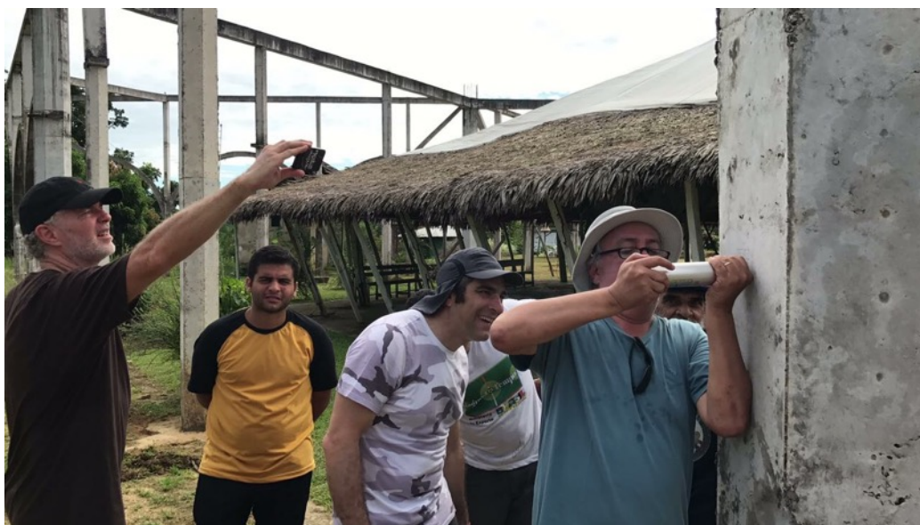
Ingenieros analizando el suelo y las fundaciones, y realizando mediciones en la estructura de hormigón
